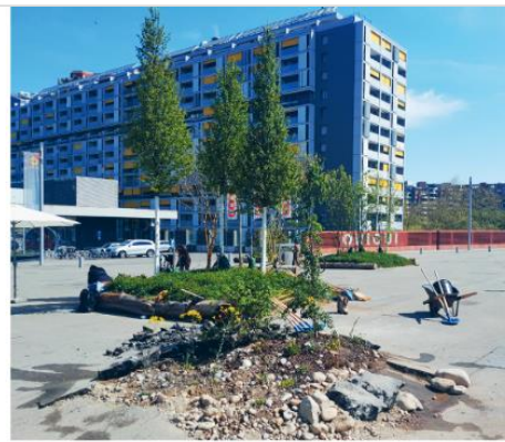
Bepflanzung und Entsiegelung wie hier auf dem Ansermetplatz in Bern führen zu einem messbaren Kühleffekt auf Hitzeinseln. Foto: Mirko Winkel
